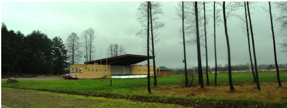
Rys. 3. Obszar objęty opracowaniem – widok na budynek sceny plenerowej wraz z infrastrukturą towarzyszącą (fot. P. Kosyło)
